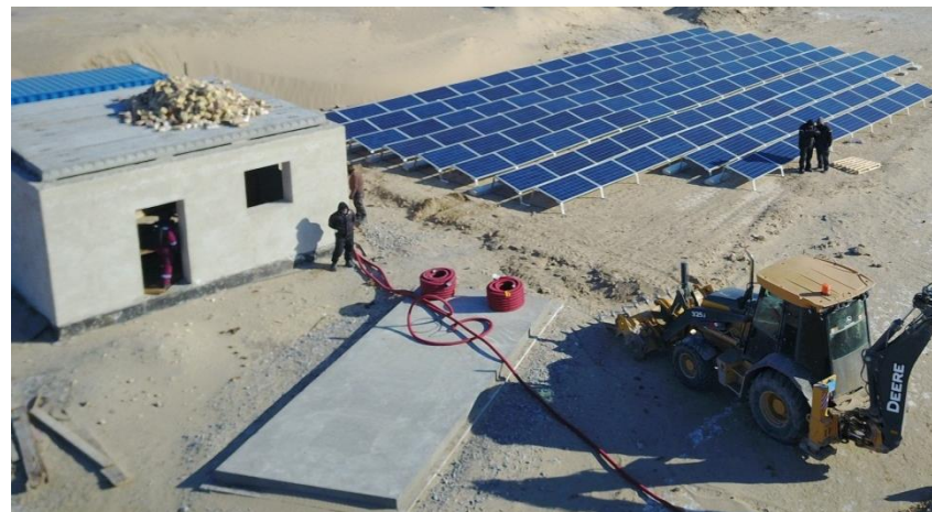
Площадки для установки солнечных батарей
