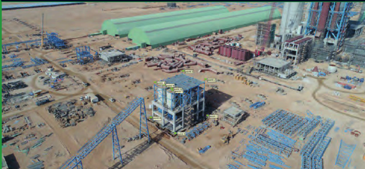
Бетонный завод, Саудовская Аравия
